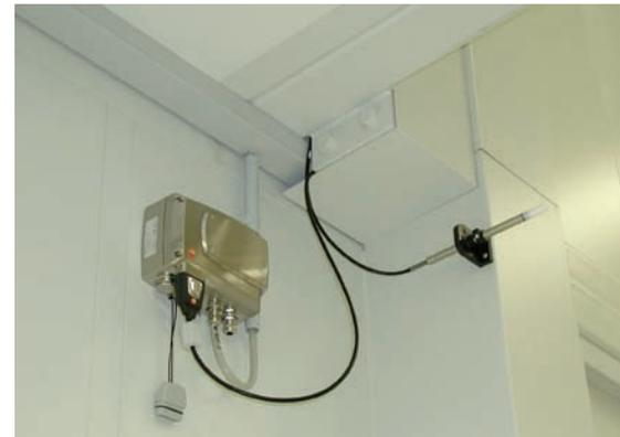
Spezielle Taupunkttemperaturfühler ermitteln die Feuchtigkeit im Raum. Die relative Feuchte von zwei Prozent entspricht dabei einer Taupunkttemperatur von  $-30\text{ °C}$ .
