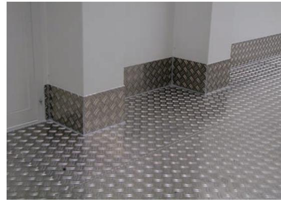
Weil bei großer Trockenheit über die Luft und einen gewöhnlichen PVC-Boden keine elektrostatischen Aufladungen mehr abgeleitet werden können, wurde ein dampfdiffusionsdichter Bodenaufbau mit Aluminiumtränenblech verwendet.
