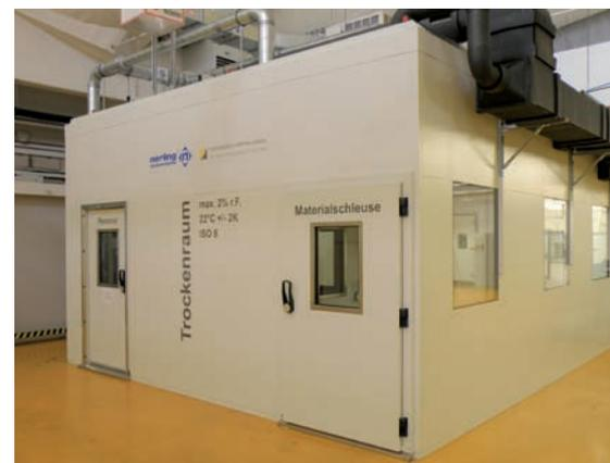
Der  $15,5\text{ m} \times 5,6\text{ m}$  große Sauberraum nach Reinraumklasse ISO 8 wurde mittels einer Verbindungstür an einen bereits vorhandenen Trockenraum angebaut.
