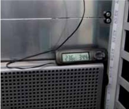
Das Bild, das an einem nicht zu warmen Julitag entstand, verdeutlicht die Differenz zwischen Zu- und Abluft: Die hereinströmende Außenluft ist mit 23,6 °C deutlich kühler als die Abluft mit immerhin schon recht kuscheligen 34,4 °C
